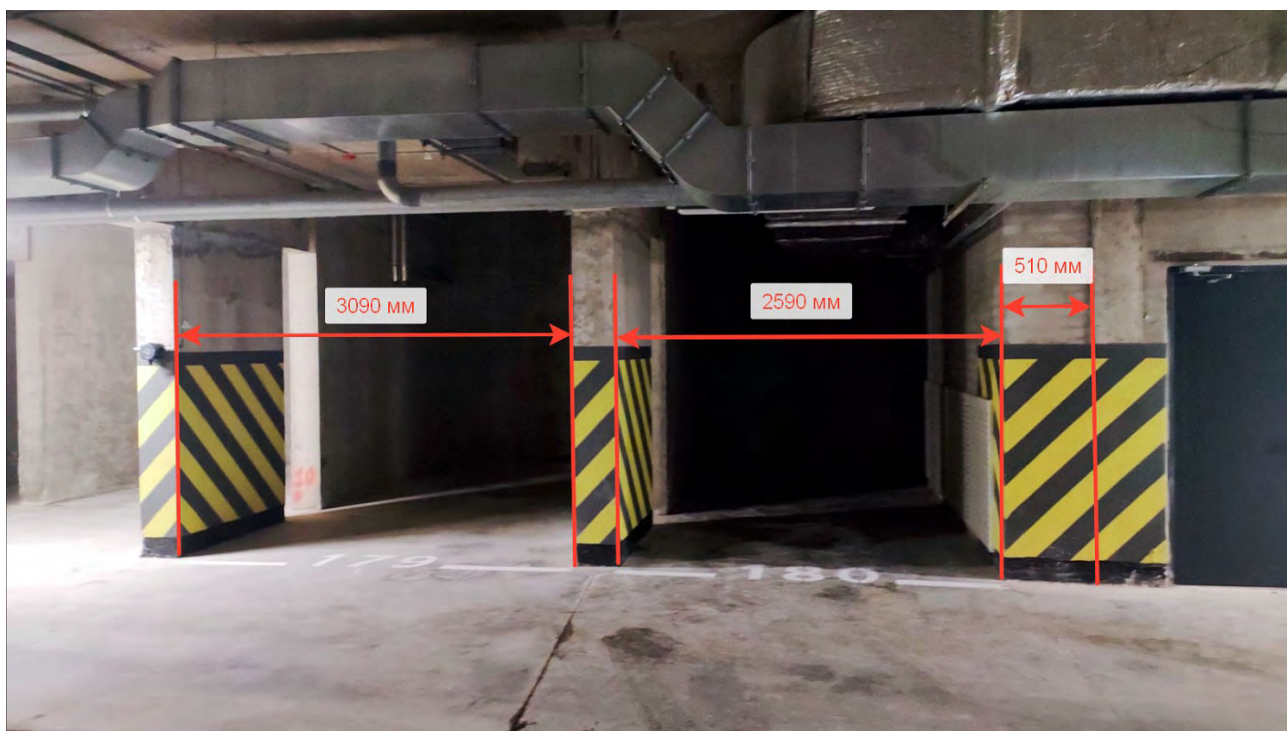
Рис. 2 Результаты измерений расстояния между стенами типового (соседнего) Машино-места с порядковым № 179 (размер 3090 мм) и исследуемого Машино-места с порядковым №180 (размер 2590 мм + размер 510 мм).
